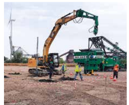
INN-Messung in einem Bohrloch
