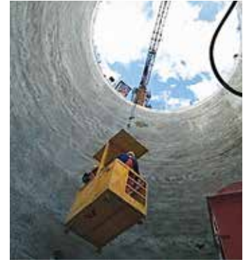
Abb. 12: Einsatz eines Arbeitskorbes für den Personentransport
