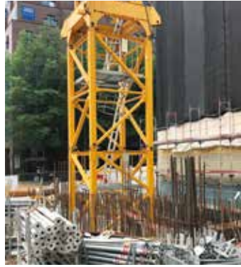
Abb. 11: Beispiel für einen Kranaufstieg
