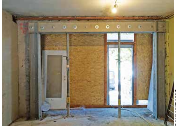
Tragende Wände wurden durch neue Stahlkonstruktionen ersetzt.
