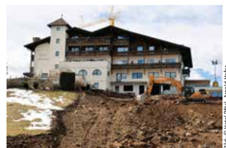
Das Hotel Pfösl vor der Sanierung
