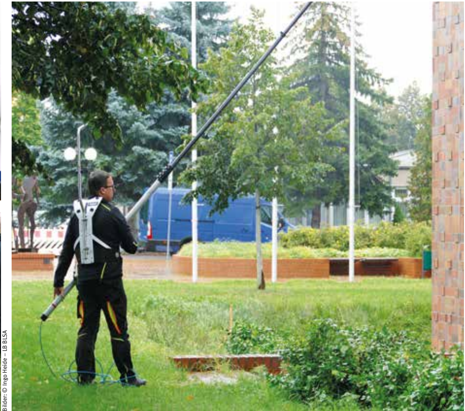
Einsatz des Teleskopstangen-Systems mit Rucksack bei der Fassadenreinigung
