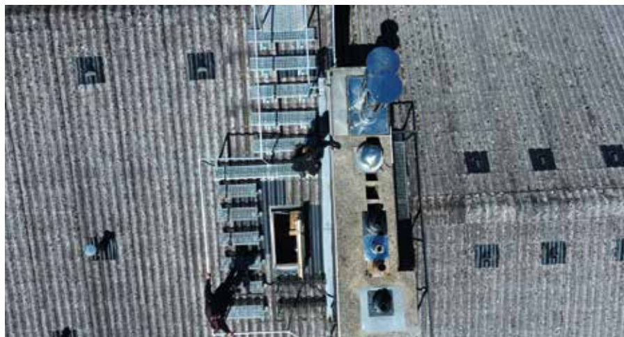
Drohneinsatz für Inspektions- oder Überprüfungsaufgaben über einem Dach zur Feststellung von Beschädigungen
