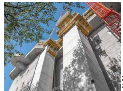
Am Bunkerkragen wurde die Selbstkletterschalung SKE50 plus eingesetzt.
