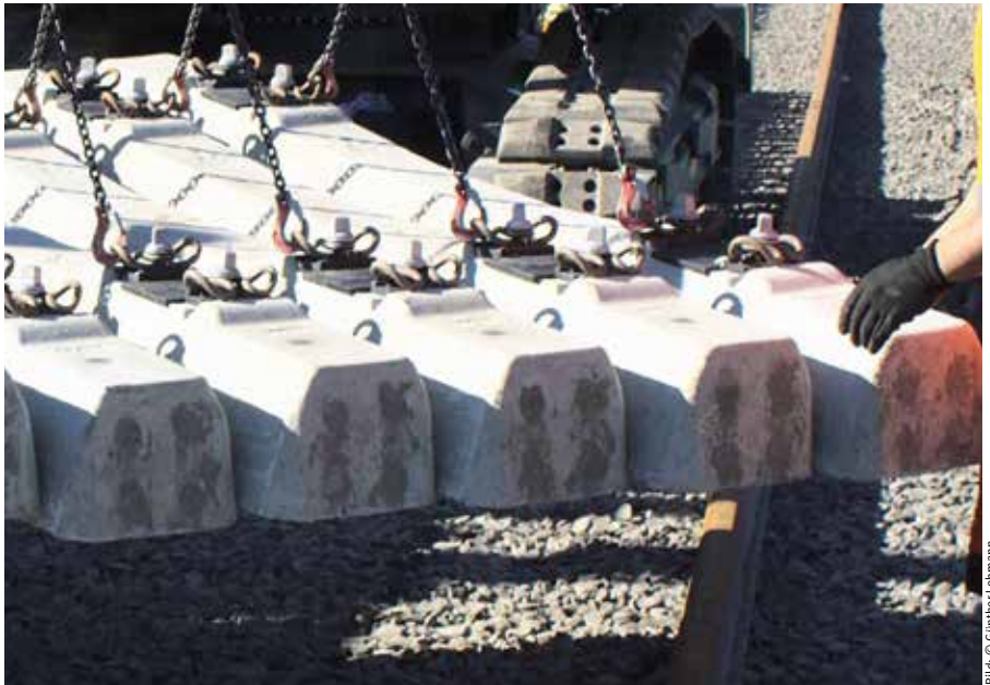
Mit einer Kette an den Spannklemmen angeschlagene Weichen im W-Oberbau
