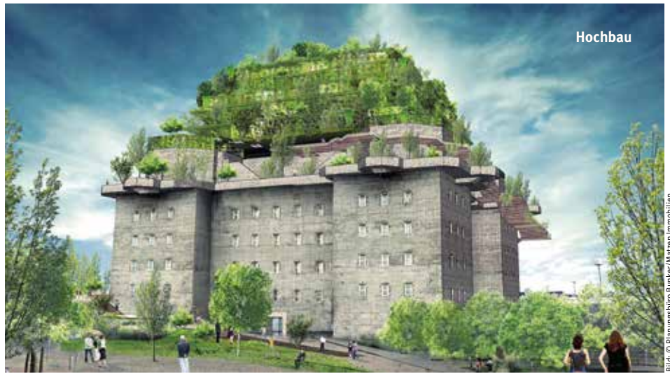
Nach der Fertigstellung wird der Bunker auf dem Hamburger Heiligengeistfeld um fünf pyramidenartige Etagen und einem üppig begrünten Dachgarten aufgestockt sein.
