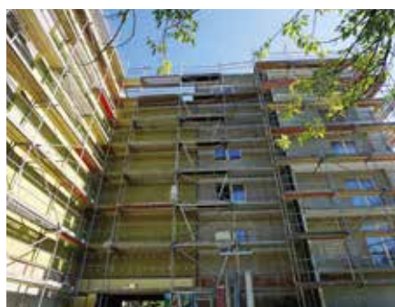
Fassaden und Dächer erhalten eine mineralische Wärmedämmung.
