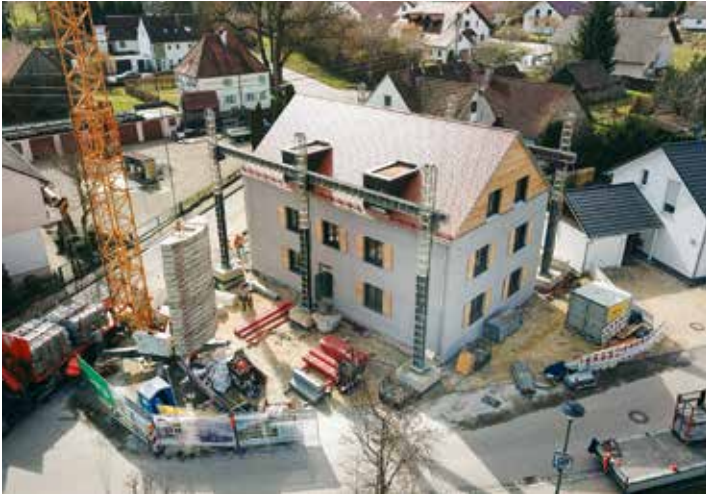
Das im 3-D-Druck hergestellte Mehrfamilienhaus in Wallenhausen vor dem Ausbau
