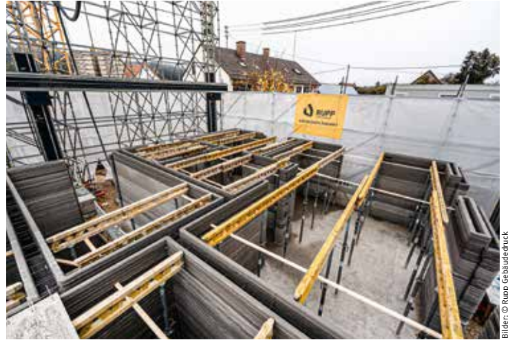
Die ersten gedruckten Haus-Elemente auf der konventionell hergestellten Kellerdecke
