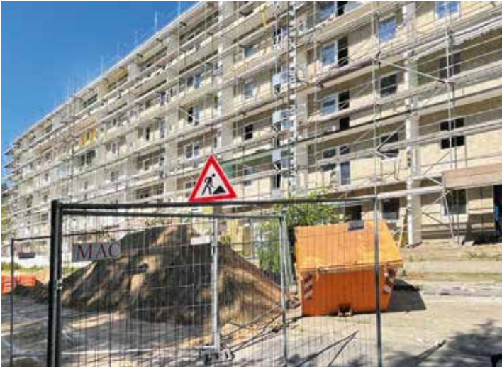
Bauzäune sichern Fußwege für Passanten.
