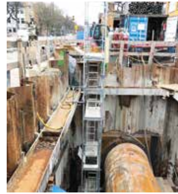
Abb. 9: Gerüst mit innenliegendem Leiteraufstieg
