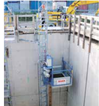
Abb. 5: Transportbühne in eine Baugrube
